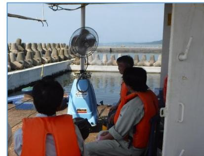
クレーン付台船にミスト扇風機を設置し、海上作業での熱中症予防に利用しています。
