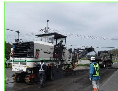
路面切削作業では、NETIS登録の集塵装置付きの路面切削機を使用し、粉塵の抑制対策に努めました。
