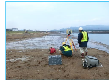
出来形測量状況（レーザー・スキャナー）
