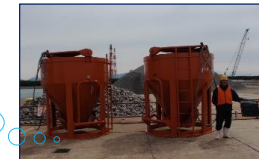
コンクリート打設で使用する 容量 5m 3 ホッパー
