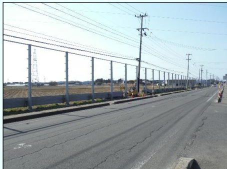
- 荒町現場状況 -
