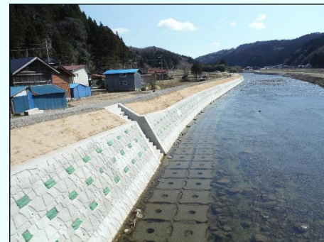
- 鮎川現場状況 -
