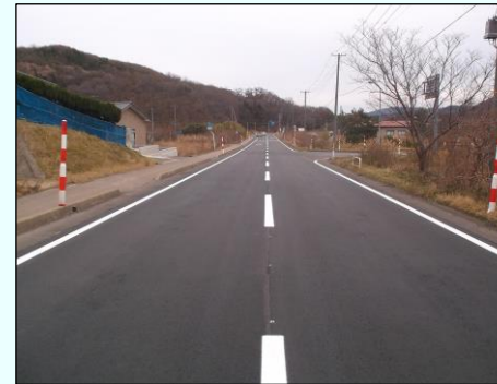
- 道路整備現場 -
