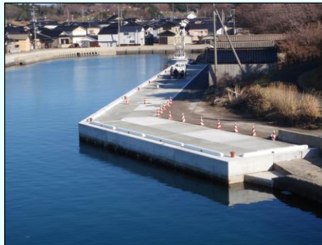
- 物揚場整備現場 -
