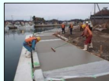
◀ 現場の取組み ▶
