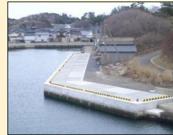
品質向上への取組みでは冬期のコンクリート打設時の凍害対策として硬化促進剤入りの材料の調達や、スロープコンクリートの沈下など最終工程への影響を防止する為に段階的な裏込め材の自主試験の実施を行いました。また積極的な創意工夫・地域への貢献を実施した事なども評価され高評価を頂きました。今後も、高品質での顧客への引き渡しとなるよう徹底した現場管理を行いたいと思っております。
